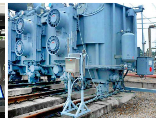
● Мобильный (переносной) комплекс контроля и технической диагностики силовых трансформаторов.
