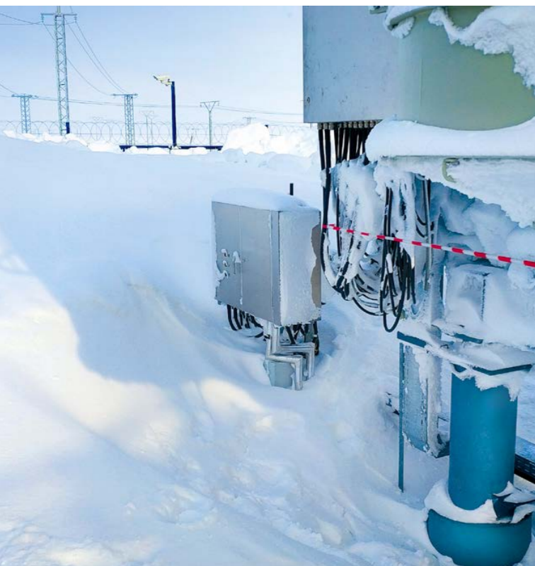
● Опыт установки газоанализатора в экстремальных условиях (до -35°C при установке, до -50°C при эксплуатации) с дистанционным мониторингом через 3G.
