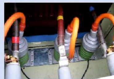
Установленные датчики 80 пФ
