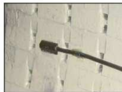
Датчик плотности магнитного потока TFPProbe Iris Power, приклеенный к зубьям статора турбогенератора
