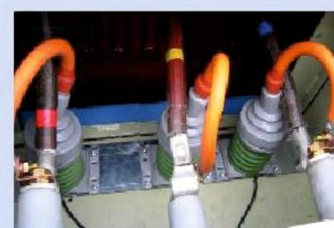
Установленные датчики 80 пФ
