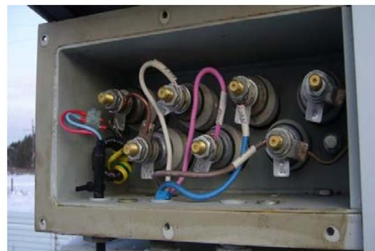
Распределительная коробка с тороидальным трансформатором тока, повешенным на заземляющий провод нижнего конденсатора
